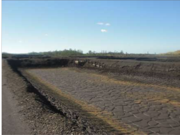
Figura 5 - Vista parcial das bacias de decantação da Unidade Mineira Verdinho.
