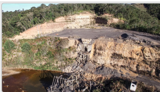
Contaminação de uma nascente de rio com metais pesados em uma boca de mina subterrânea abandonada que explodiu em 1984, matando 31 trabalhadores. Urussanga, Santa Catarina, Brasil, 2021. Foto aérea: Juliano Bueno de Araújo.
